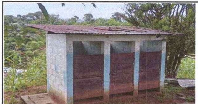
Foto 6: aquí se muestra que las láminas del baño están mal.
